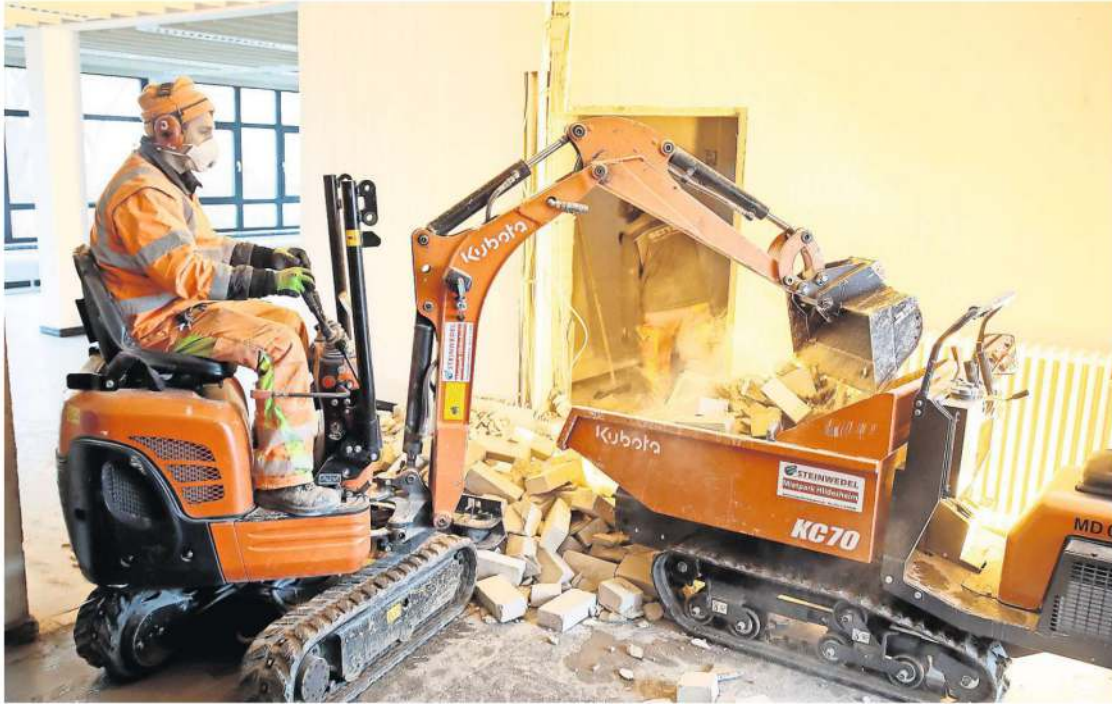
Johann Sawatzki beseitigt im Erdgeschoss mit seinem Minibagger die Überreste einer abgerissenen Mauer. Die Bauherren lassen derzeit zahlreiche Wände einreißen, um mehr Platz für die einzelnen Lerngruppen der Montessorischule „Welt.Räume“ sowie die Kindertagesstätte „Kinderhaus“ zu erhalten. FOTOS: WERNER KAISER
